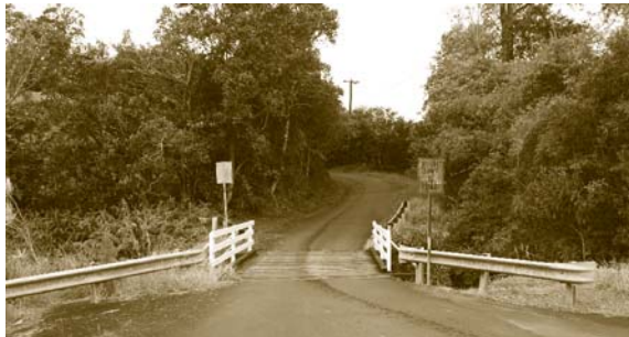
44-1 Kaapahu, Paauilo Mauka Rd., Wooden**
